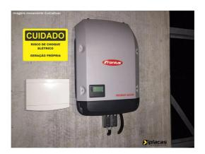
As placas de sinalização, "Cuidado - Risco de choque elétrico - Geração própria", tem como objetivo advertir e sinalizar o perigo de choque elétrico proveniente de um gerador de energia elétrica: solar, eólica, hidráulica ou moto geradores.
